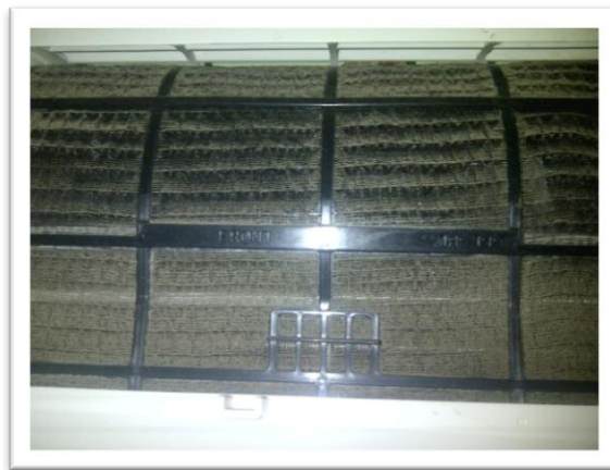
Gambar 4. Kondisi filter AC dengan ketebalan debu sedang
